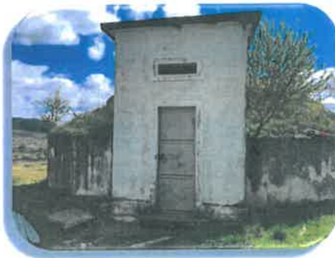
Foto 2 - Reservatório de Peredo dos Castelhanos
